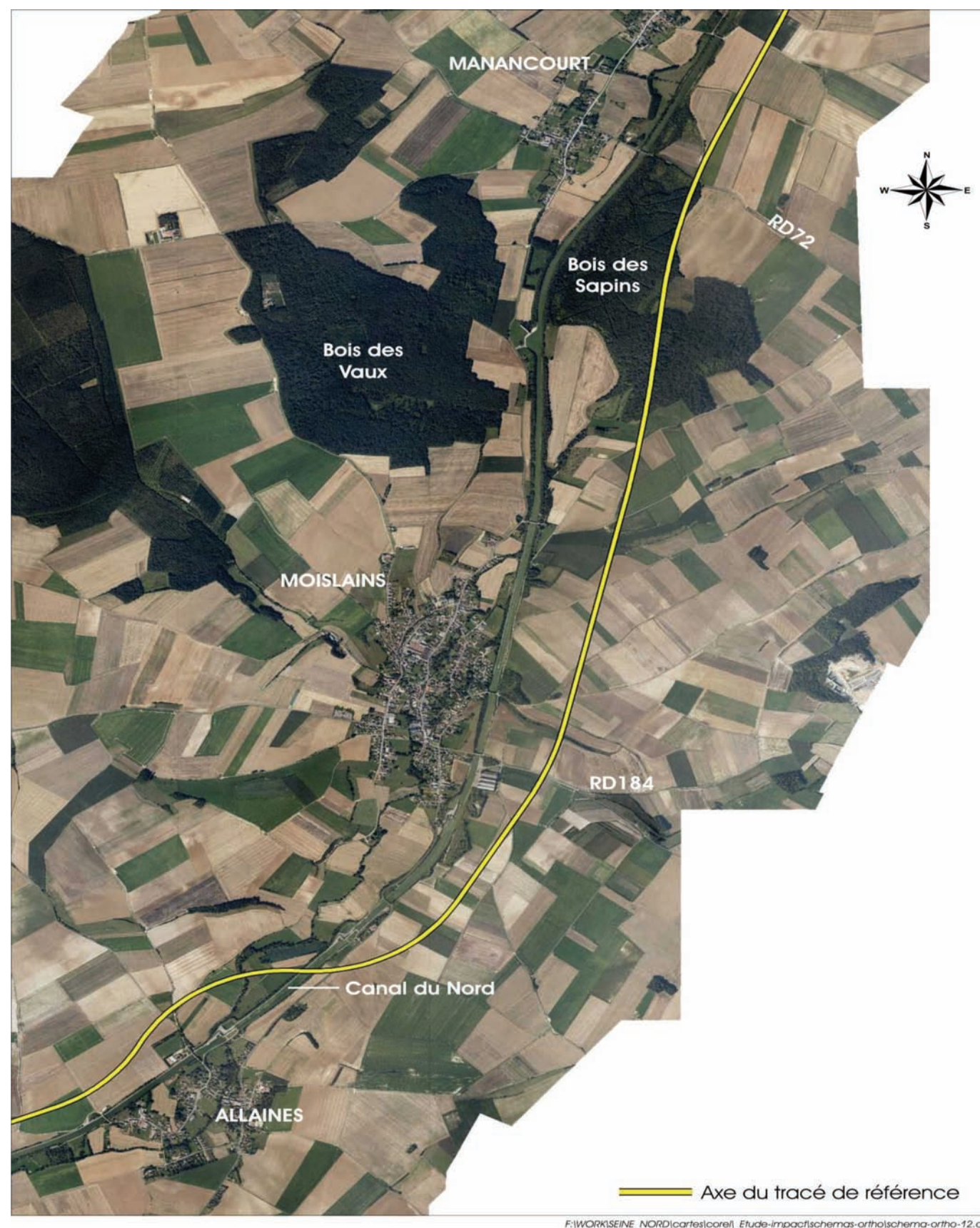
Vue aérienne de l'ensemble du secteur 12 : Moislains / Etricourt-Manancourt (Source : SETEC International)
