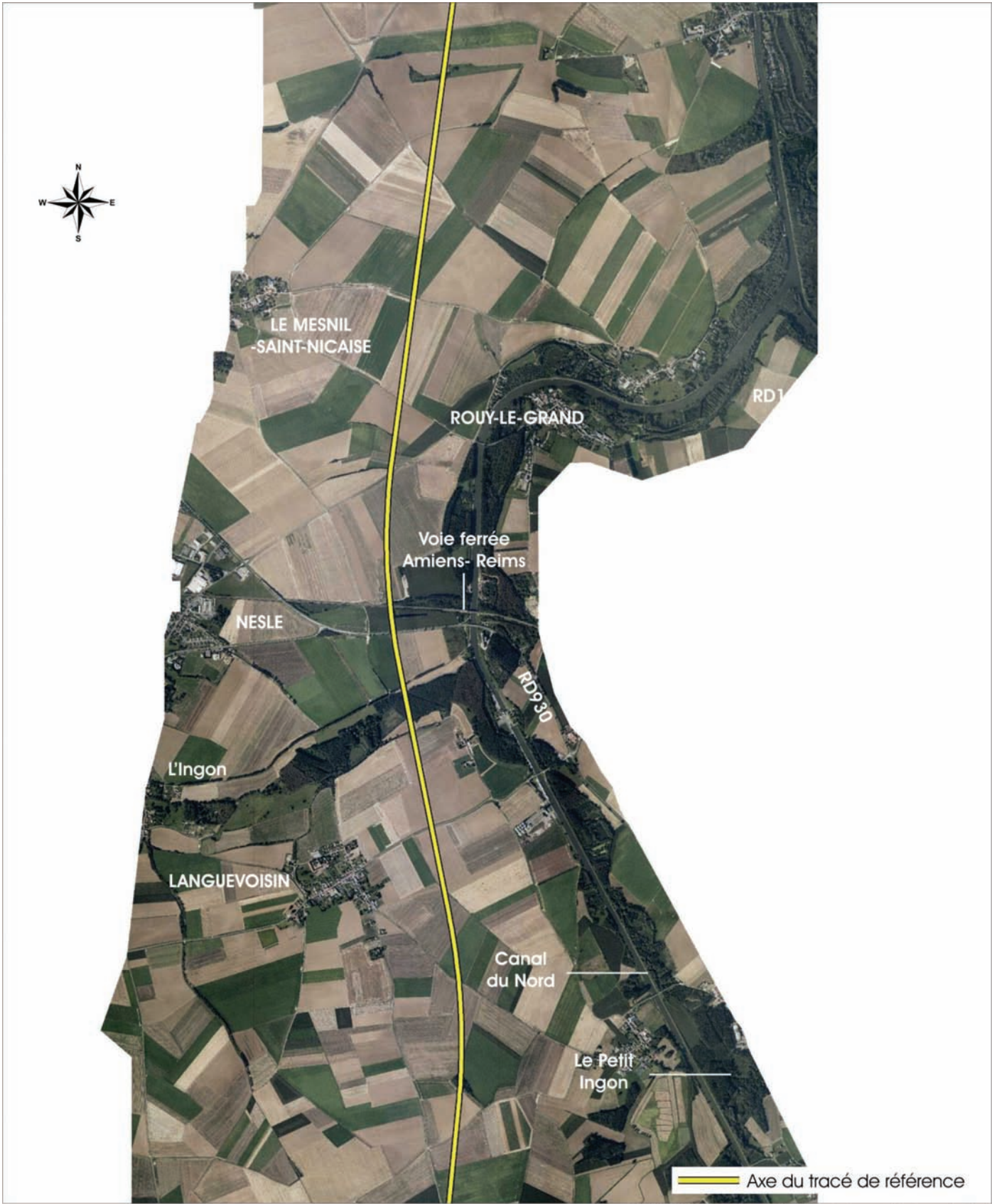
Vue aérienne de l'ensemble du secteur 7 : Moyencourt / Béthencourt sur Somme (Source : SETEC International)
