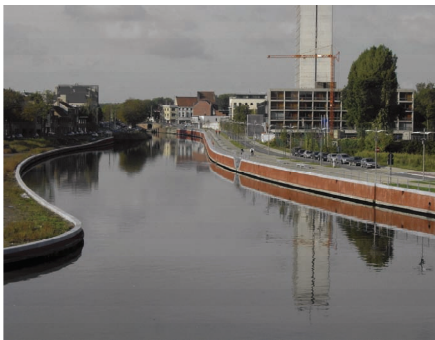
L'aménagement de la Lys dans Courtrai permet le passage des convois Vb en alternat
