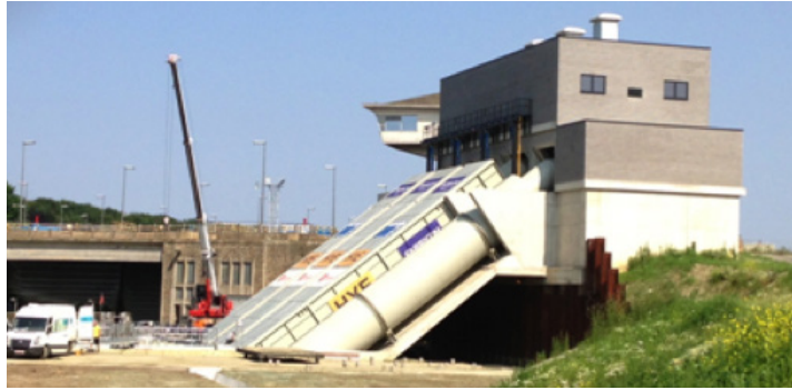
Exemple d'équipement de production hydroélectrique en cours d'installation sur certaines écluses du canal Albert
